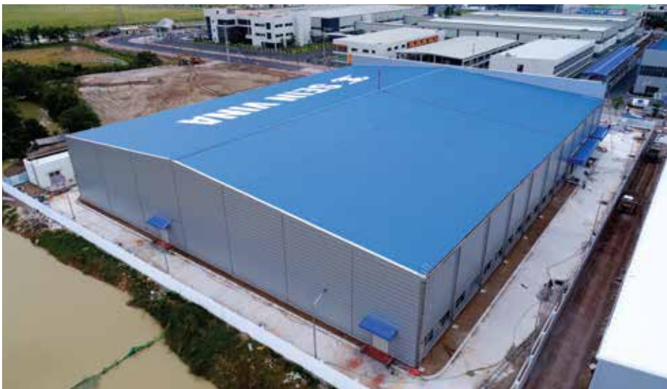
Nhà máy Sein Vina - Bắc Ninh
