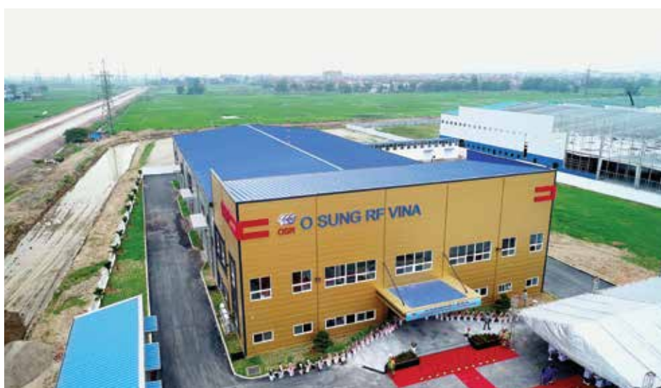
Nhà máy O Sung Vina - Bắc Ninh
